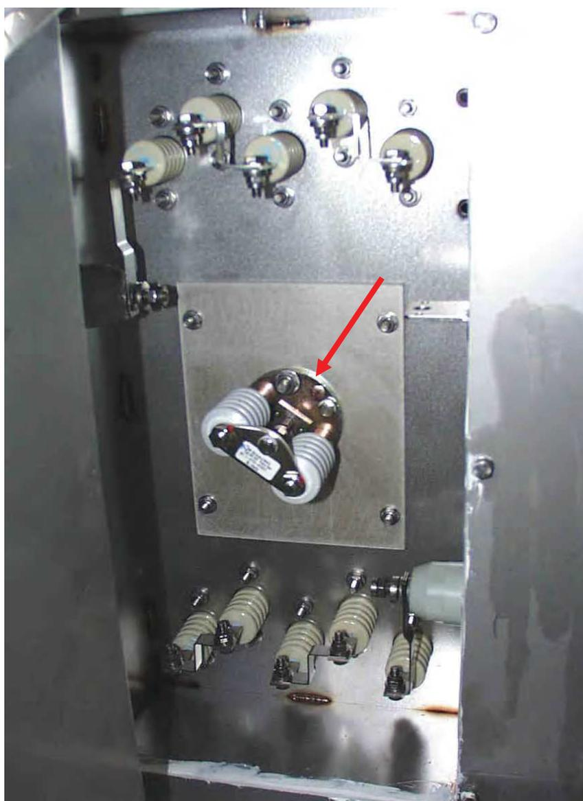
**Fig. 1 Collocazione dell'eutettico di protezione della batteria elettrica AT**
