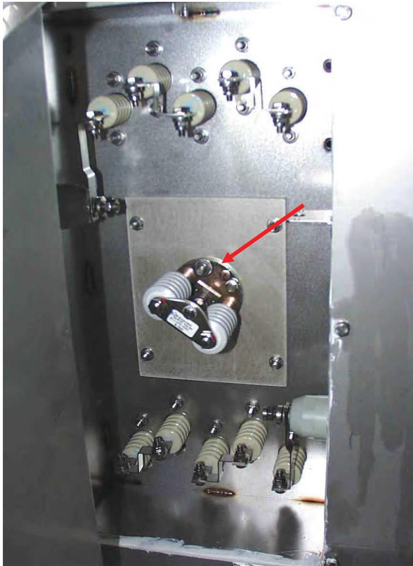
Fig. 1 Collocazione dell'eutettico della batteria elettrica AT
