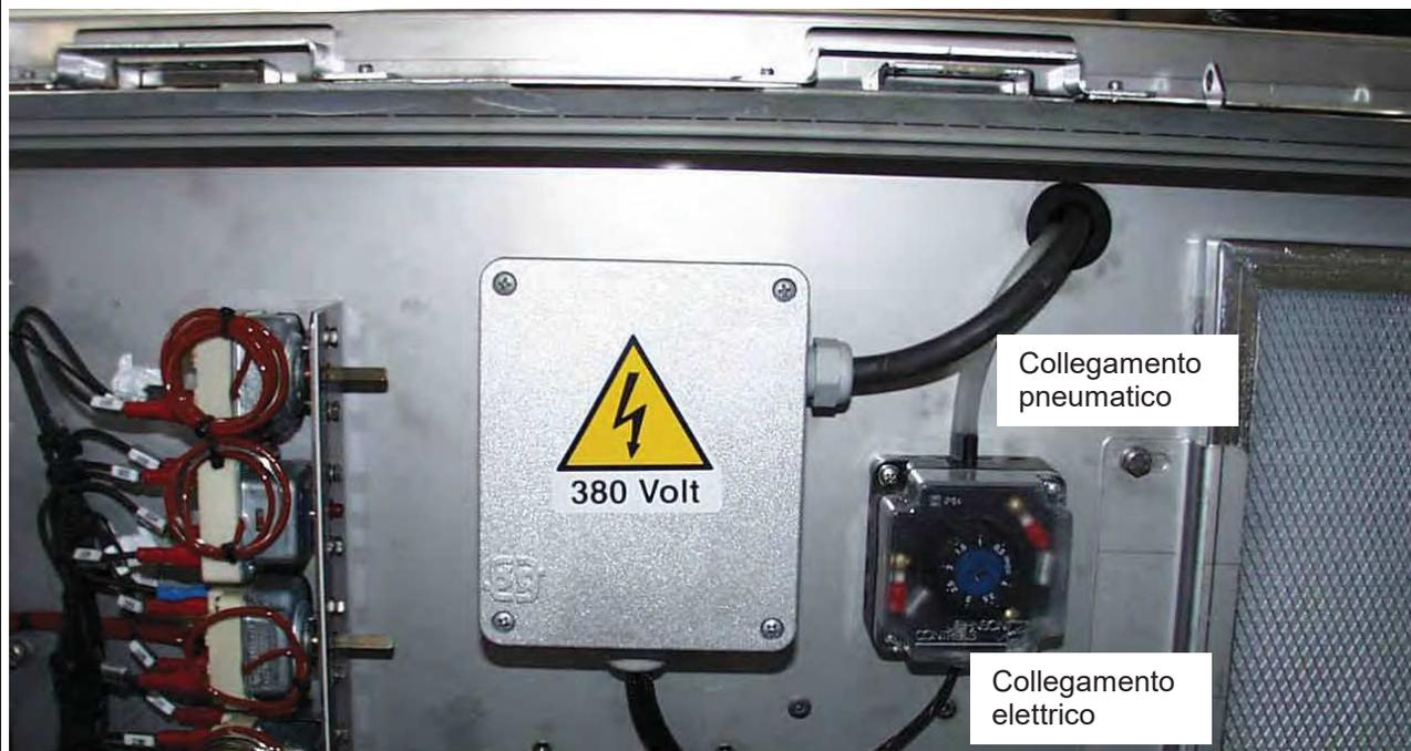
**Fig. 1 Collocazione del pressostato differenziale aria**
