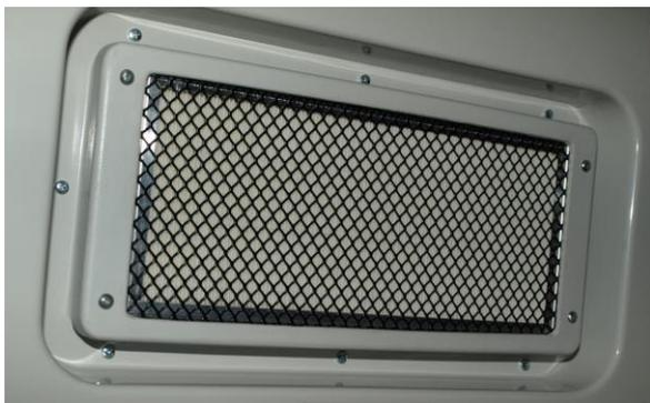
Verificare la pulizia del filtro d'aspirazione posto nel pannello controsoffitto all'interno della cabina. Il filtro intasato di peluria, capelli, polveri, e simili è da aspirare o soffiare con l'aria; eventualmente da sostituire.
