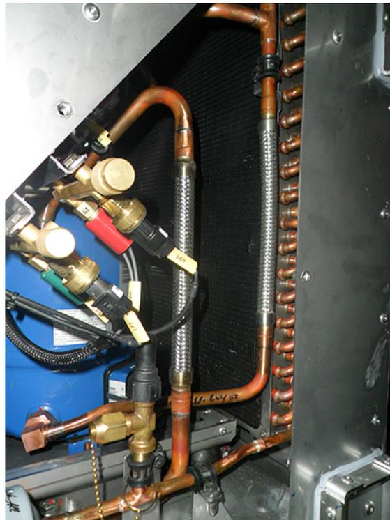
Fig. 3 Dettaglio della batteria condensante del modulo HVAC di cabina
