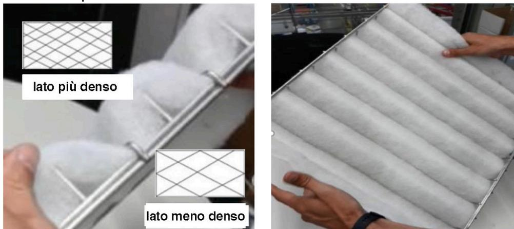
17. Inserire i due filtri (telai completi di feltro) all'interno dell'unità HVAC (Fig. 3) prestando attenzione ad inserire il telaio del filtro nella direzione corretta (Fig. 4).
