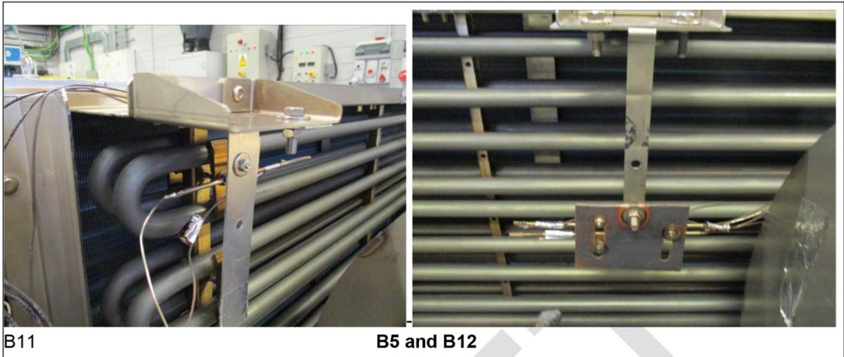
**Fig. 2** Termostati di sicurezza di sovratemperatura (nota: i termostati B5 e B12 sono montati separatamente)
