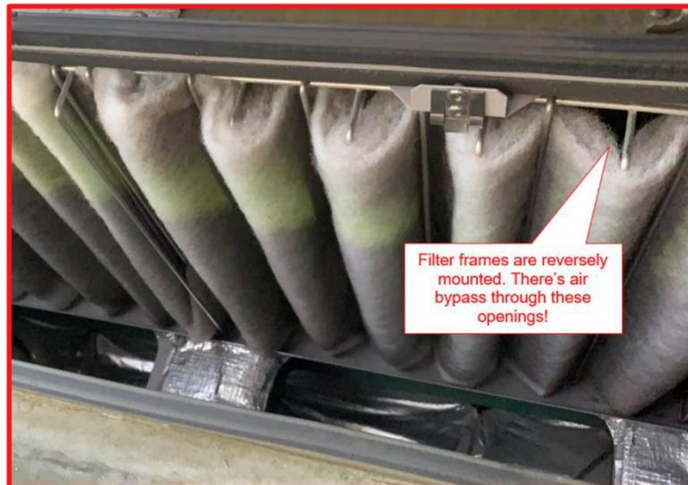
**Nota:** nell'immagine che riporta l'installazione ERRATA il telaio del filtro è montato al contrario. L'aria passa attraverso aperture e non viene filtrata.
