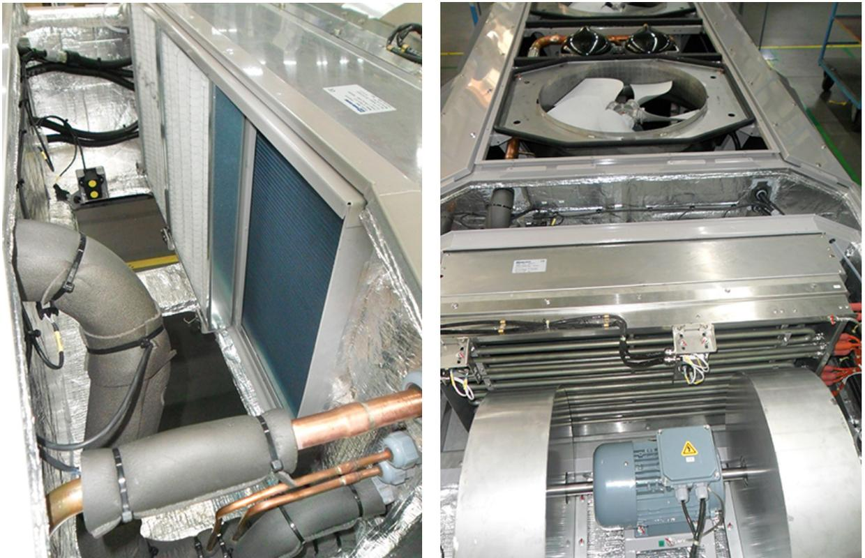
Fig. 3 Dettaglio della batteria evaporante del modulo HVAC di comparto
